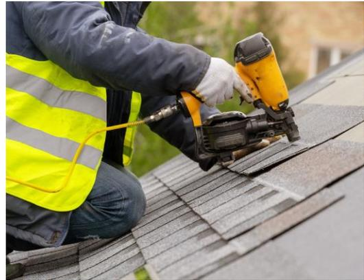
Las herramientas neumáticas deben revisarse para asegurarse de que la herramienta esté bien sujeta a la manguera de aire.
